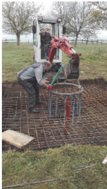
Vorbereitung des Sockels mit Ringanker, Foto privat
