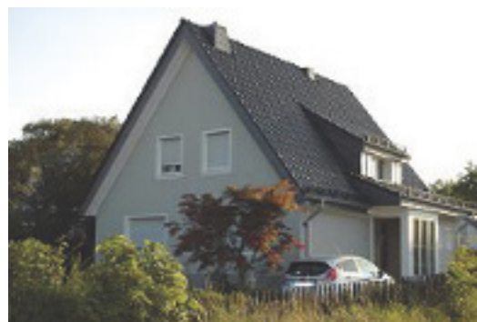
Geschafft (Zellulosedämmung, Solaranlage, Fenster)
