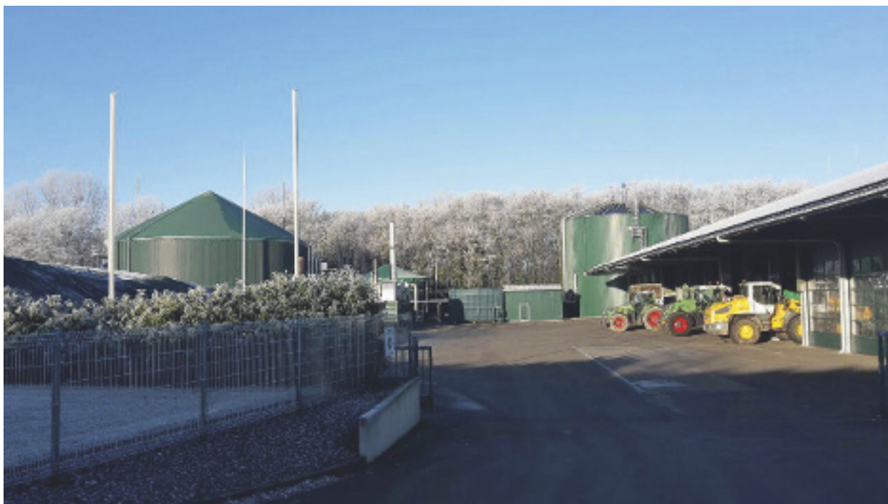
Gesamtblick auf die Biogasanlage in Odendorf
