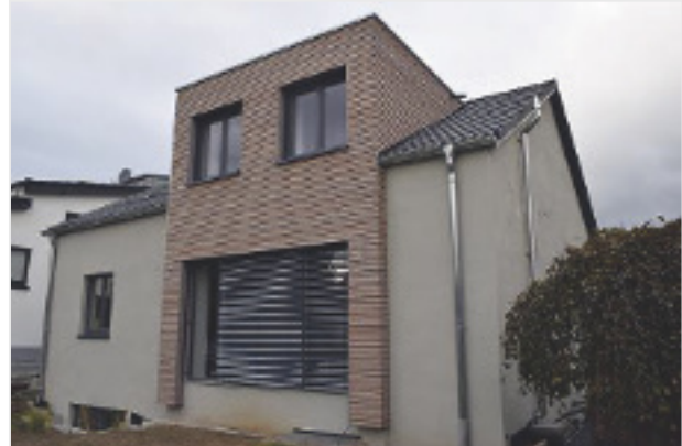
einmal nach der Sanierung
