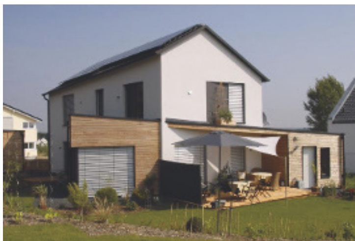
Neubau unseres Hauses, Sommer 2014
