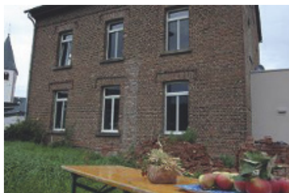
Durch eine Pelletheizung werden 90% CO 2 gespart
