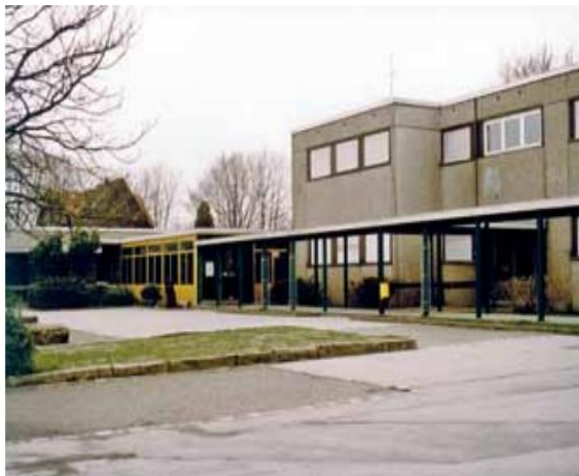
Der Schulhof der Paul-Dohrmann-Schule vor der Umgestaltung
